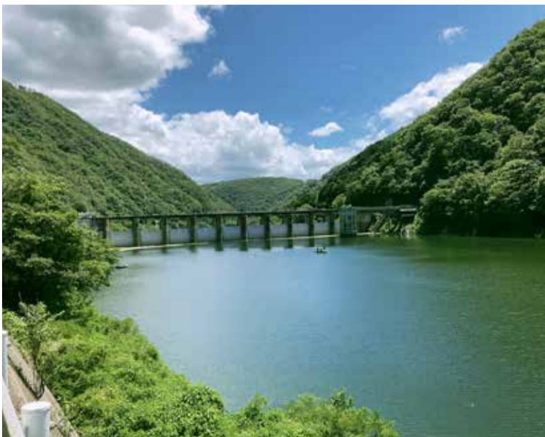
本年も大きな災害がない事を祈ります: 旭川ダム
