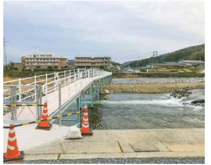
幸福橋(しあわせ橋)
