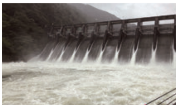
旭川ダムの放流
